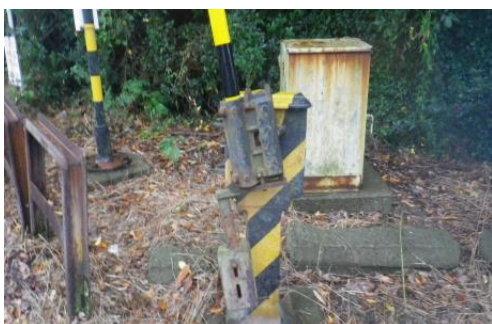
浅間台踏切遮断機更新 施工前
