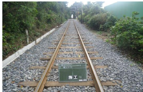
君ヶ浜～犬吠間 施工後
