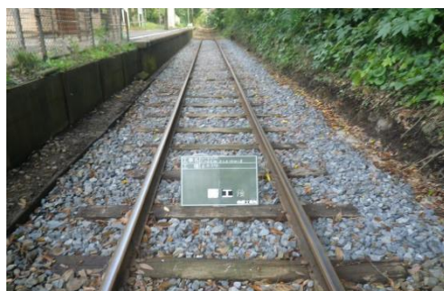
本銚子駅付近 施工後
