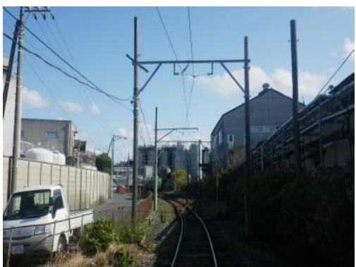
銚子～仲ノ町間 施工前
