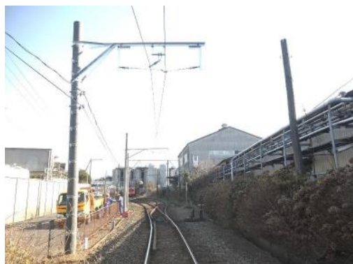
銚子～仲ノ町間 施工後
