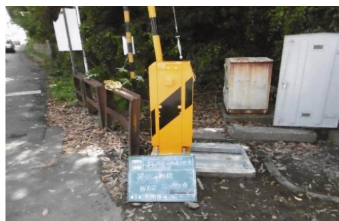
浅間台踏切遮断器更新 施工後
