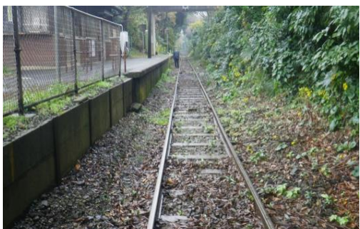
本銚子駅付近 施工前
