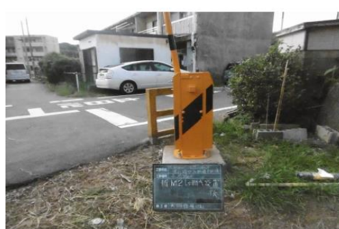
長崎踏切遮断機 施工後
