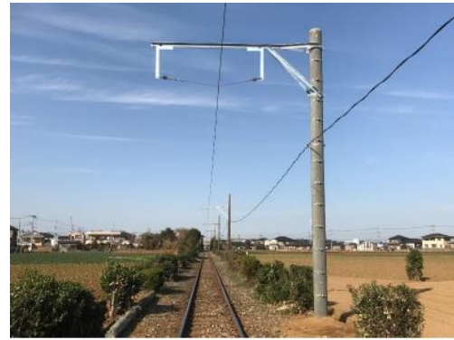
笠上黒生～西海鹿島間 施工後
