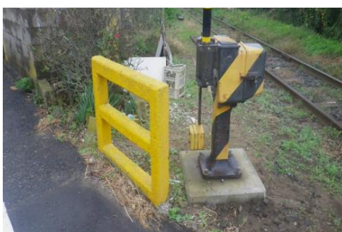
長崎踏切遮断機 施工前
