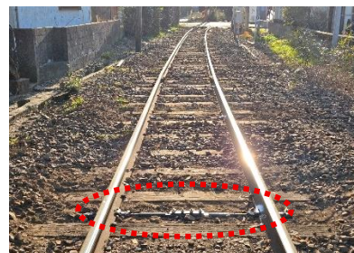
施工後の仲ノ町駅構内
