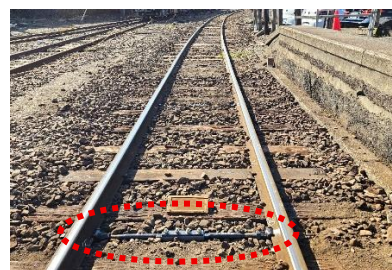
施工後の仲ノ町駅構内
