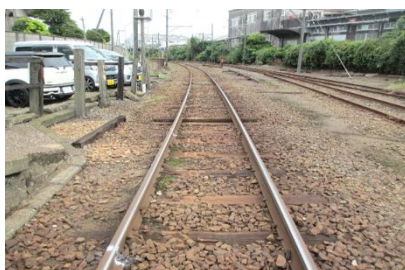
施工前の仲ノ町駅構内
