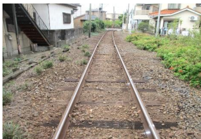
施工前の観音駅構内
