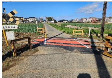
更新後の 14 号踏切
