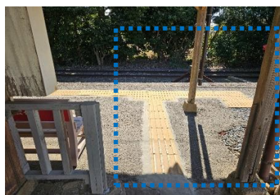
施工後 起点方ホーム端(出入口)
