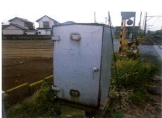
(海鹿島大踏切制御箱更新工事 施工前)
