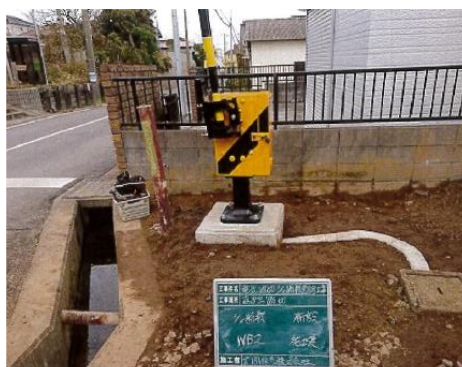
（海鹿島踏切遮断機更新工事 施工後）
