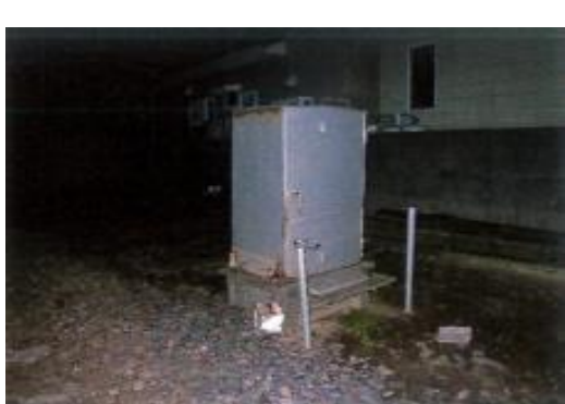
(金矢踏切制御箱更新工事 施工前)
