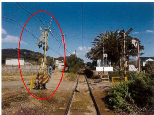
(君ヶ浜踏切遮断機更新工事 施工前)
