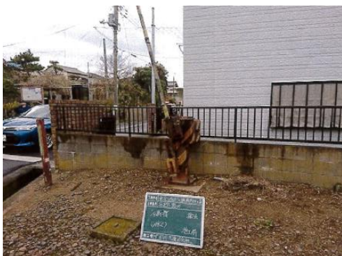
（海鹿島踏切遮断機更新工事 施工前）
