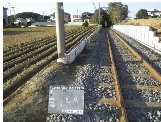
(君ヶ浜～犬吠間 施工後)
