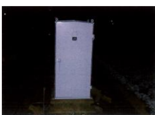
(海鹿島大踏切制御箱更新工事 施工後)
