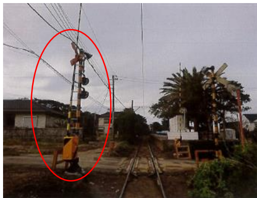
(君ヶ浜遮断機更新工事 施工後)
