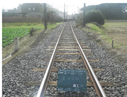
(君ヶ浜～犬吠間 施工後)
