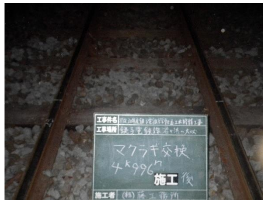
(君ヶ浜～犬吠間 施工後)
