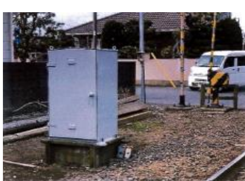
(金矢踏切制御箱更新工事 施工後)
